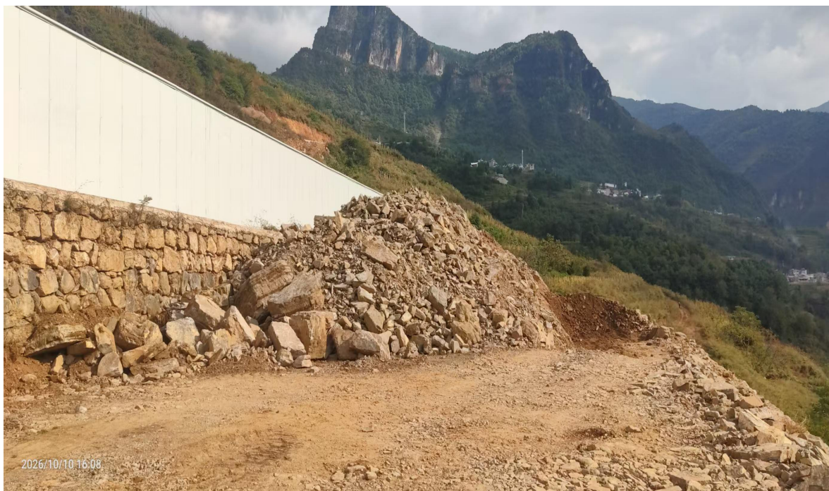
3 号堆放点照片
