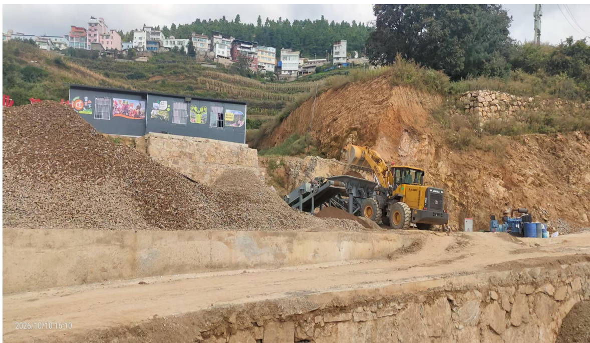
2号堆放点照片
