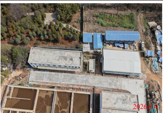
新建生产用房、出水在线监测房现状
