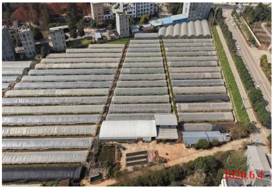
项目南侧现状
