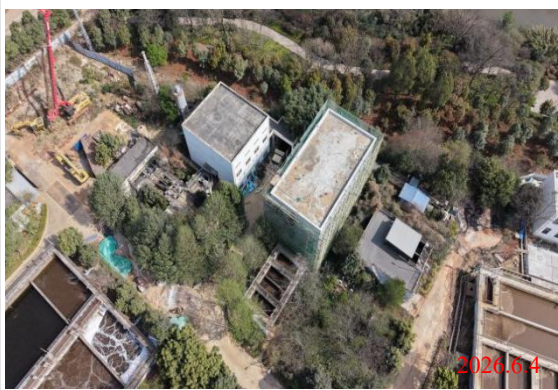
粗格栅及进水泵房、细格栅、旋流沉砂池、 现有污泥脱水机房现状
