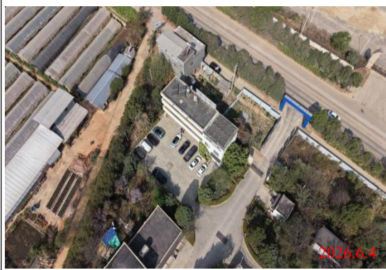
厂区入口处、综合楼现状
