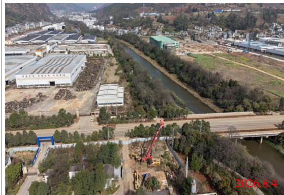
项目西侧现状
