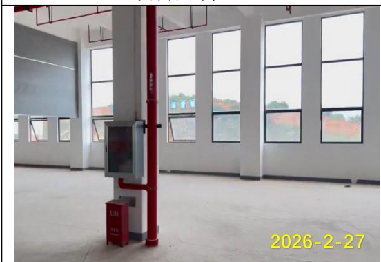
项目北侧区域现状
