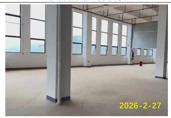
项目南侧区域现状
