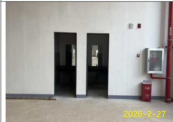
项目厂房入口
