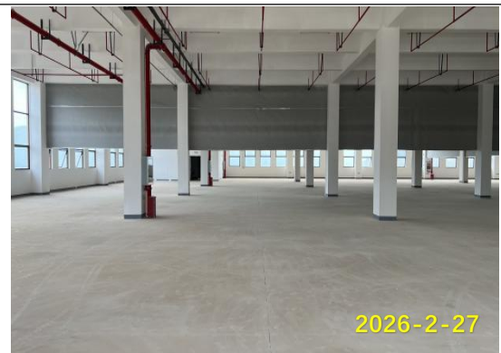
项目租用厂房现状
