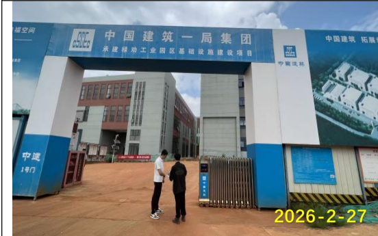
禄劝产业园区标准化厂房入口
