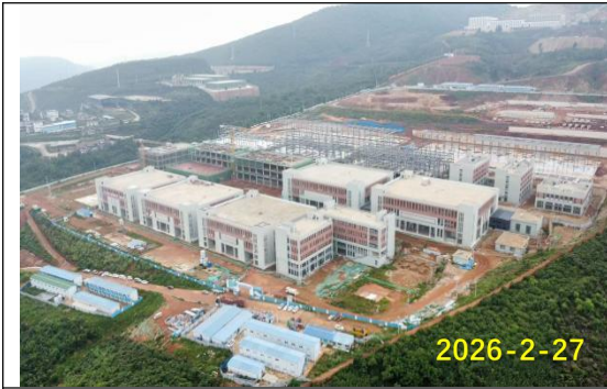
禄劝产业园区标准化厂房全景
