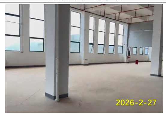
项目南侧区域现状
