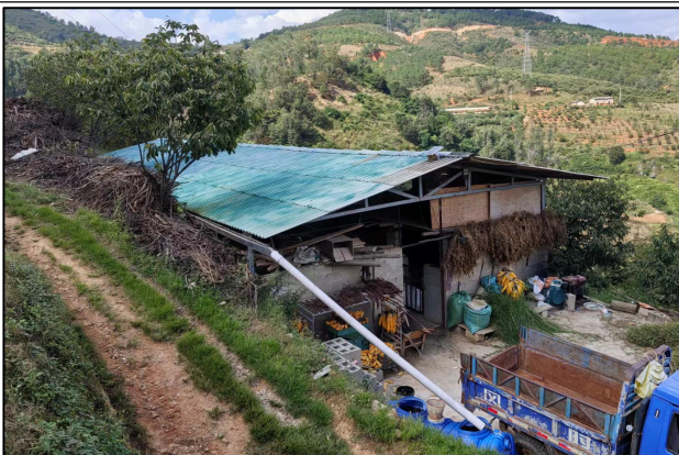
塔基 P14~P15 之间线路边导线南侧 28m 处山里果箐村 (刘国华家) 居民楼
