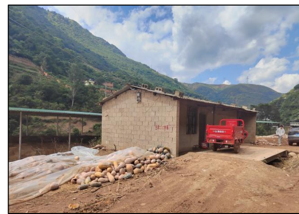
塔基 P5~P6 之间线路跨越的南瓜临时收购点, 与边导线水平距离 0m, 垂直距离 170m
