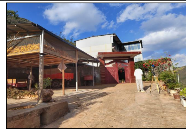
塔基 P19~P20 之间线路边导线北侧 40m 处蒿枝箐村 (赵金红家) 居民楼
