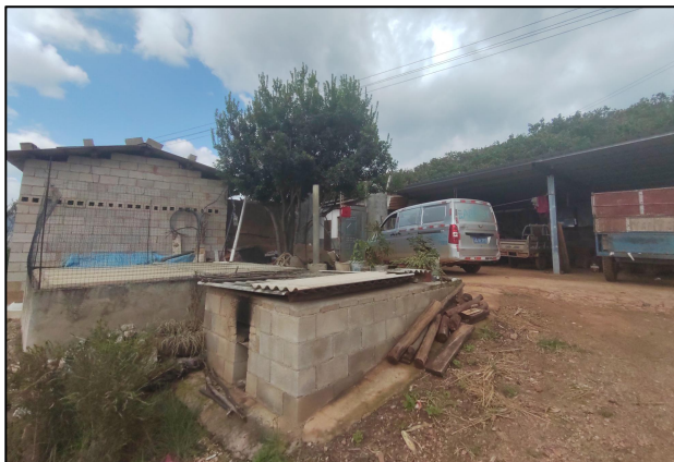
塔基 P1~P2 线路边导线东南侧约 40m 处下大山村 (陈金林家) 居民楼
