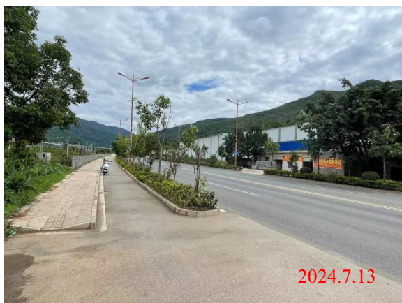
项目区西侧 G108 京昆线
