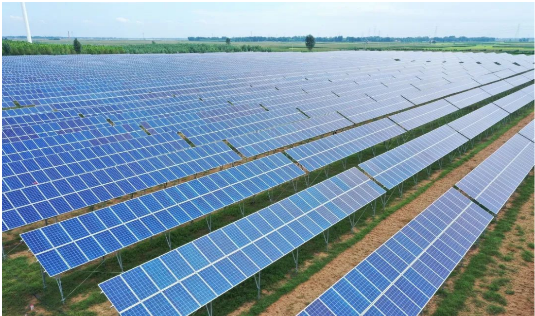
图 2-2 固定支架太阳能方阵示意图
