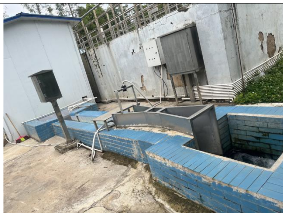
污水处理站出水口
